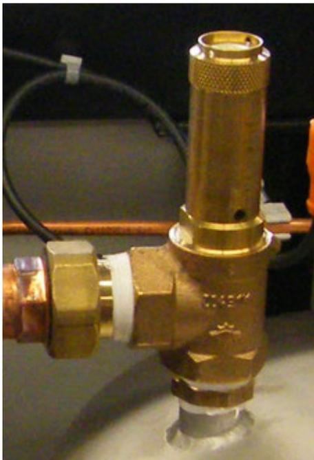
Fig. 4: Soupape de sécurité
